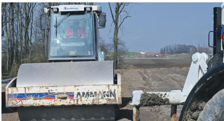
Stavba dálnice D33 se blíží k Sadové.
