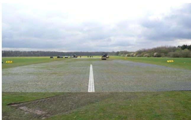
Vlevo: dílec systému Terra Grid E35; vpravo: ukázka použití systému Terra Grid E35 na letišti v Leverkusenu (SRN)
