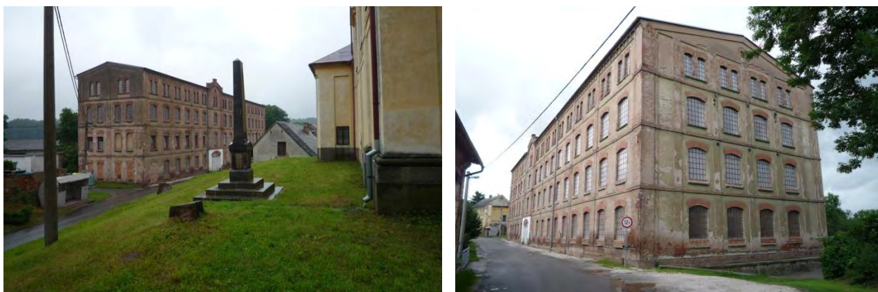
Industriální objekt bývalé elektrárny na návsi v Heřmanicích na pravém břehu Labe (foto: Veronika Šindlerová, 2012)
