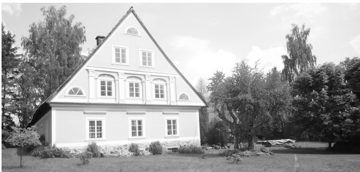
Obr.: Velmi zdařilá rekonstrukce statku broumovského typu v Křinicích. [Foto: Veronika Šindlerová, 25. 5. 2019]
