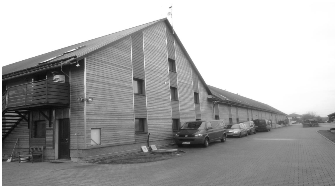
Obr.: Areál truhlárny a velkoobchodu a maloobchodu s řezivem v centru obce Kolomuty u Mladé Boleslavi. [Foto: Veronika Šindlerová, 03/2019]
