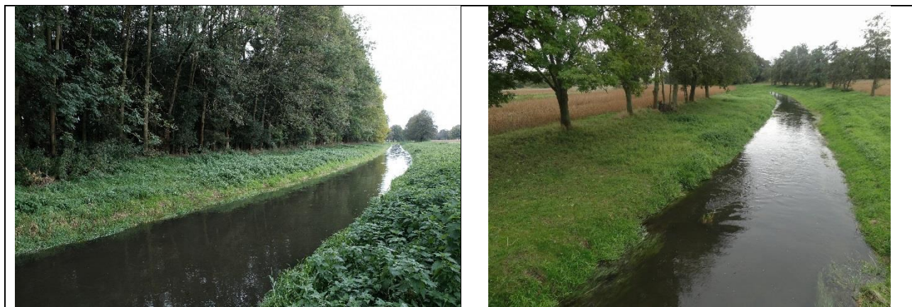
Obr. 5: Současný stav v úseku navrhovaného opatření (říjen 2019)
