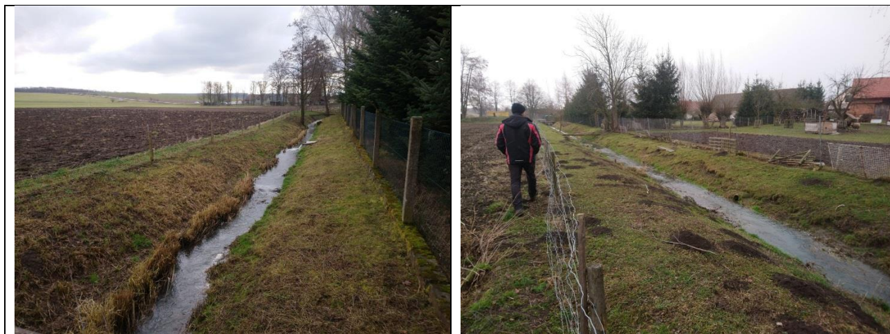
Obr. 60: Současný stav Chropotínského potoka ve spodním úseku
