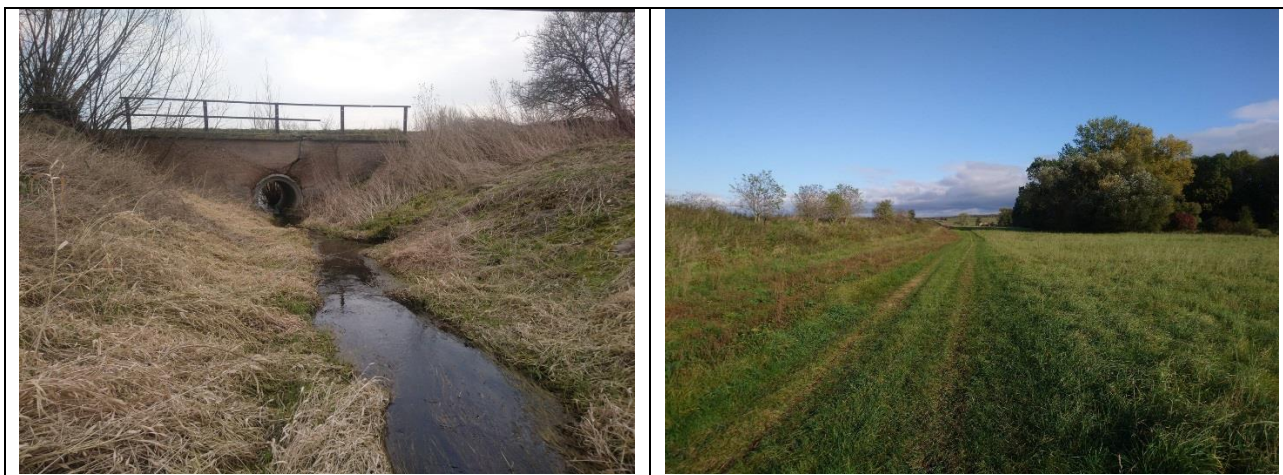
Obr. 64: Přemostění Rohenického potoka (vlevo), zemní val nad zemědělskou cestou
