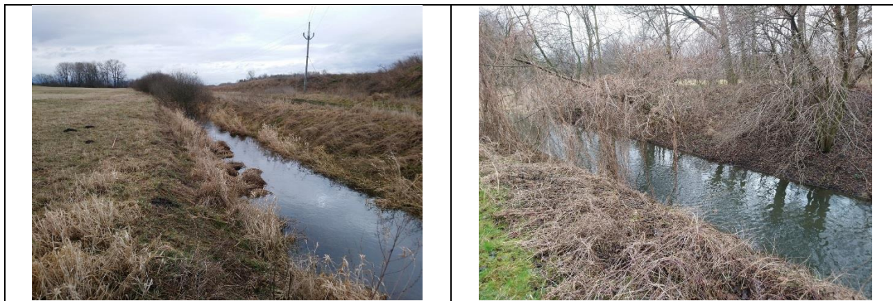
Obr. 14: Současný stav v úseku navrhovaného opatření – Litá (říjen 2019)
