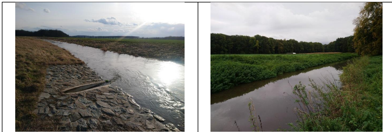
Obr. 11: Současný stav v úseku navrhovaného opatření (říjen 2019)
