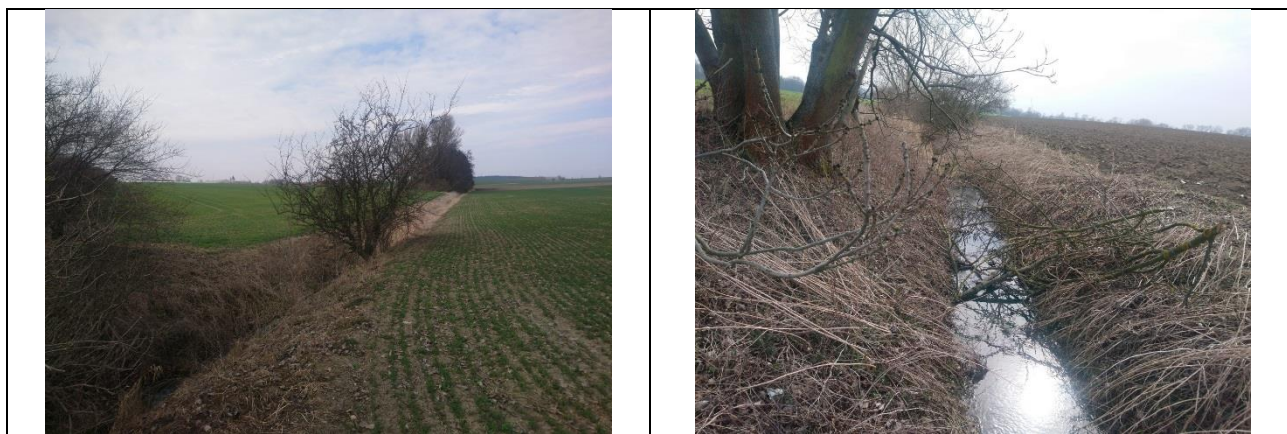
Obr. 19: Současný stav v úseku navrhovaného opatření – Sadka (říjen 2019)
