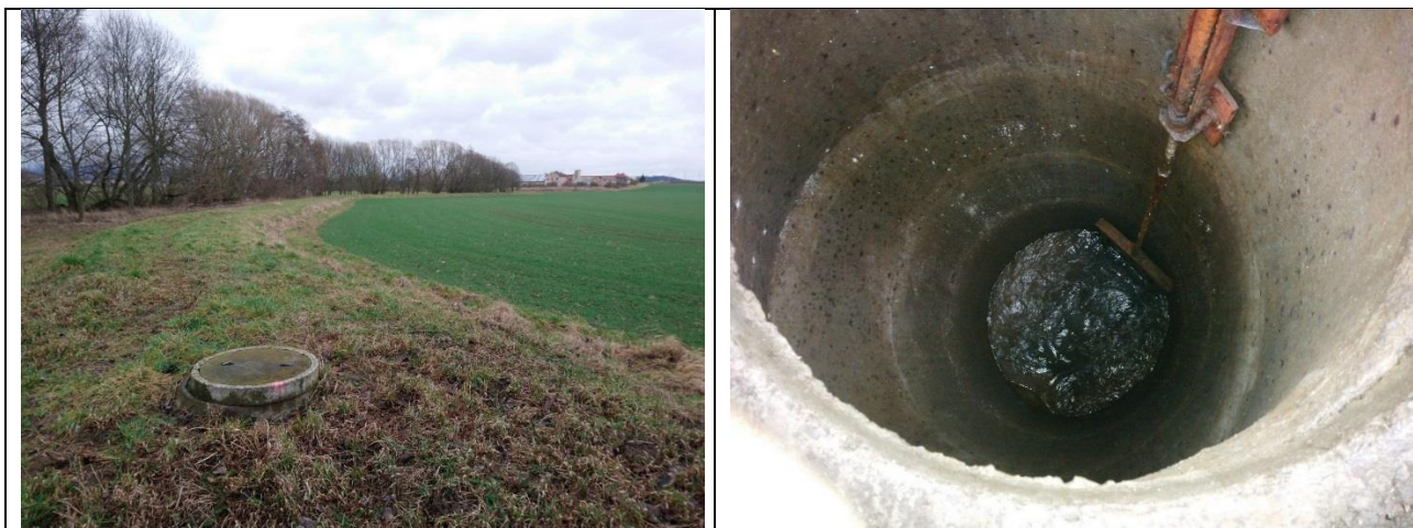
Obr. 70: Fotografie uzavíracího objektu přivaděče
