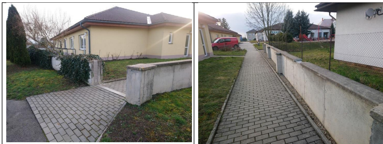
Obr. 66: Stávající ochrana citlivého objektu v Českém Meziříčí
