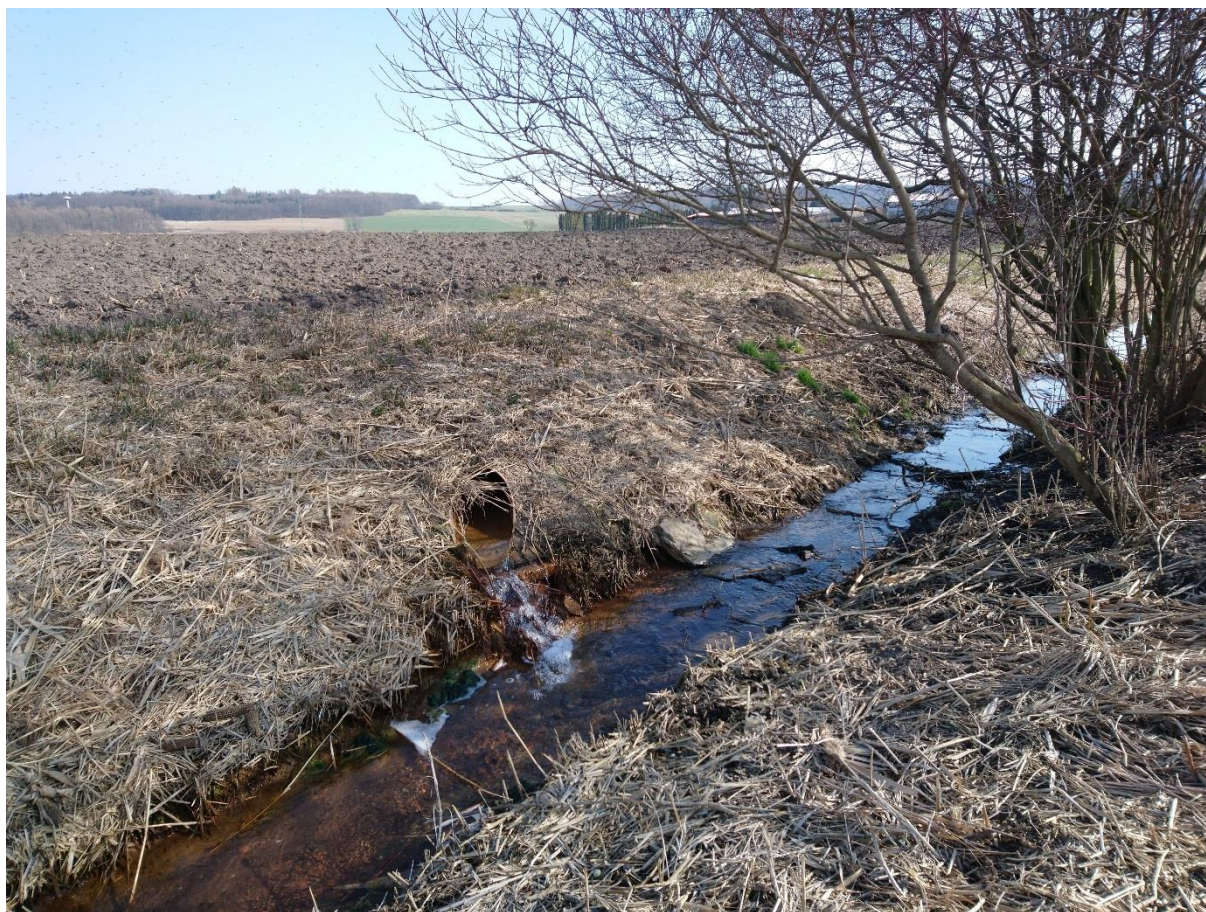
Obr. 45: Příklad vyústění odvodňovacího zařízení v lokalitě plánované revitalizace toku - Bolehošť
