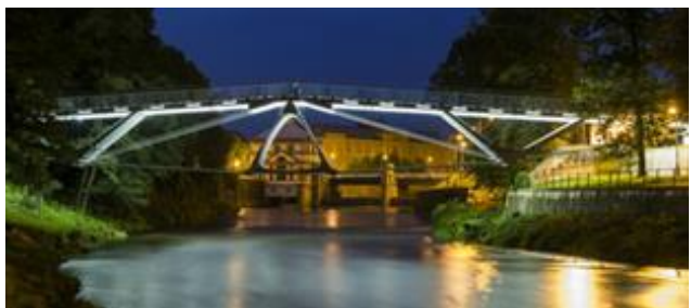
Lávka přes řeku Orlici
