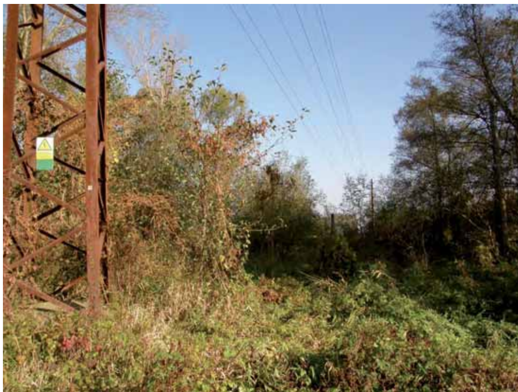
Lokalitu protíná na třech místech v J části elektrické vedení.
