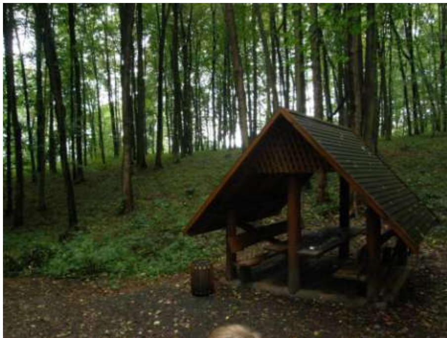
Přístřešek u přístupové cesty v SZ části
