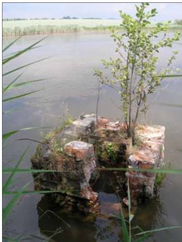
Obr. č. 4: Vypouštěcí zařízení Tureckého rybníka, stav v roce 2010.
