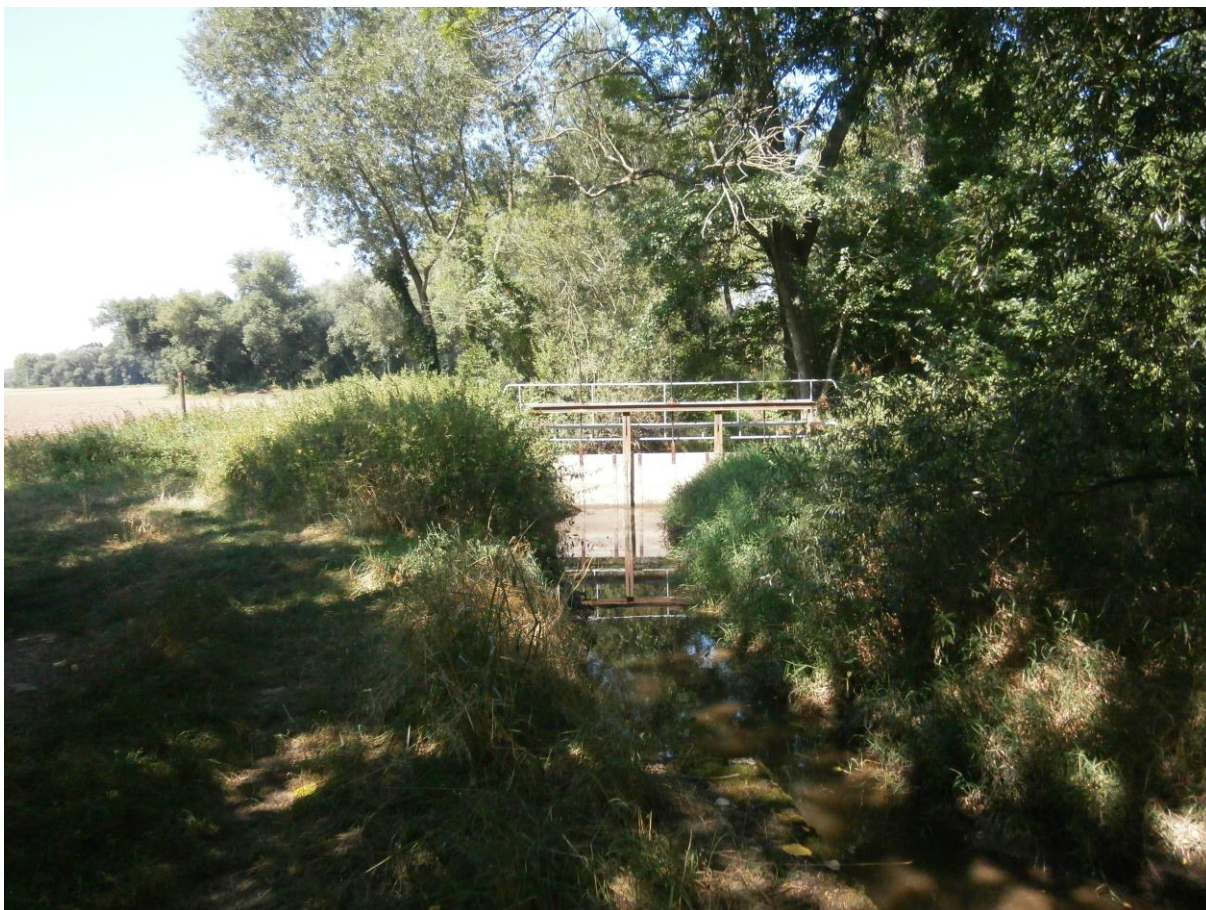
Obr. 3: Stavidlo způsobující nedostatečné průtoky ve střední části toku u jezu Stará Metuje IV v km 5,100 (6,180).
