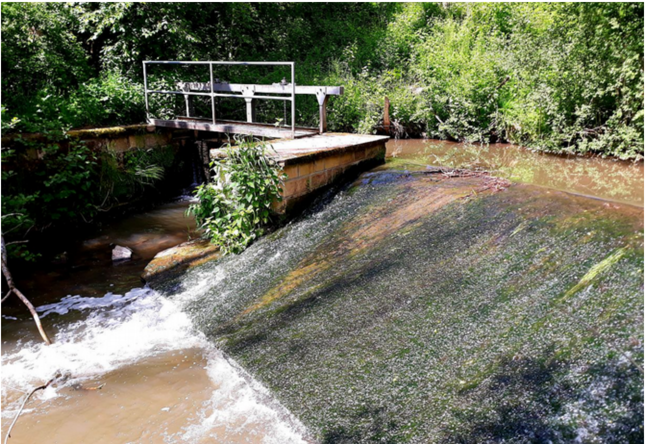
Foto 3: Jez Doubrava na 43,4, ř.km. Foto Michal Gerža, 26. 5. 2020.
