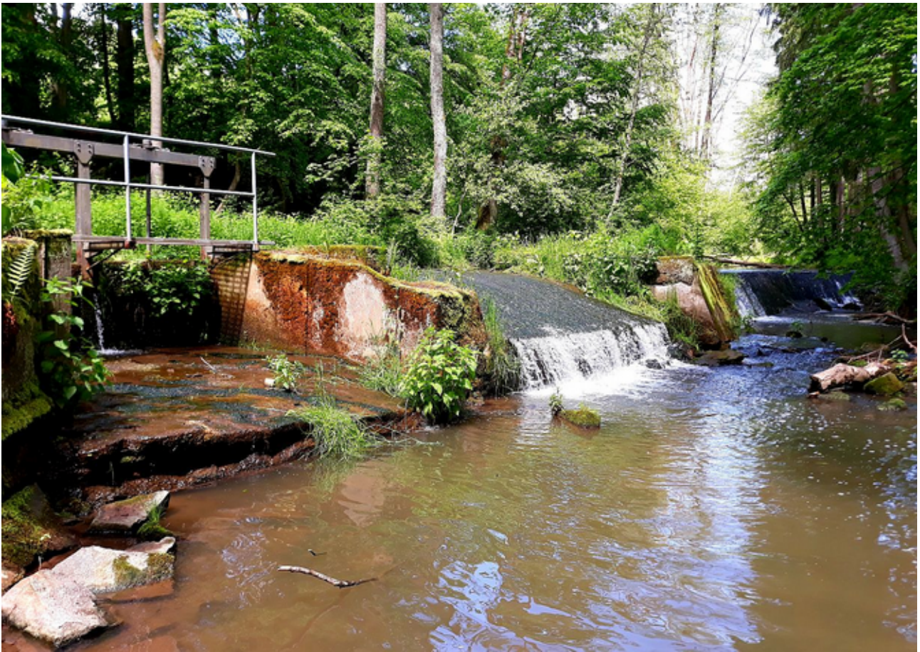
Foto 5: Jez Rozsévač na 44,48 ř.km. Foto Michal Gerža, 26. 5. 2020.
