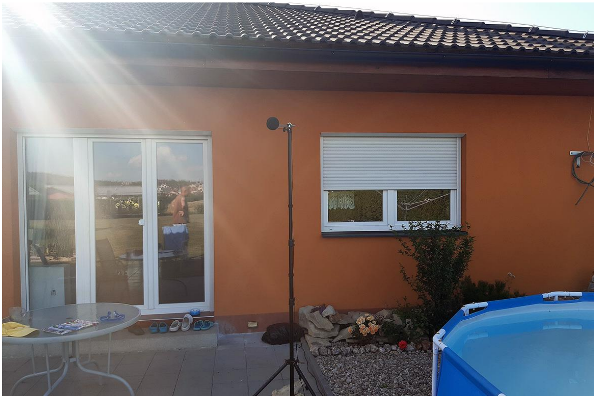
OBR. 3 Pohled na měřicí místo č. 10
