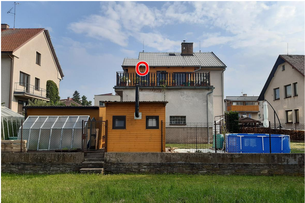
OBR. 5 Pohled na měřící místo č. 11
