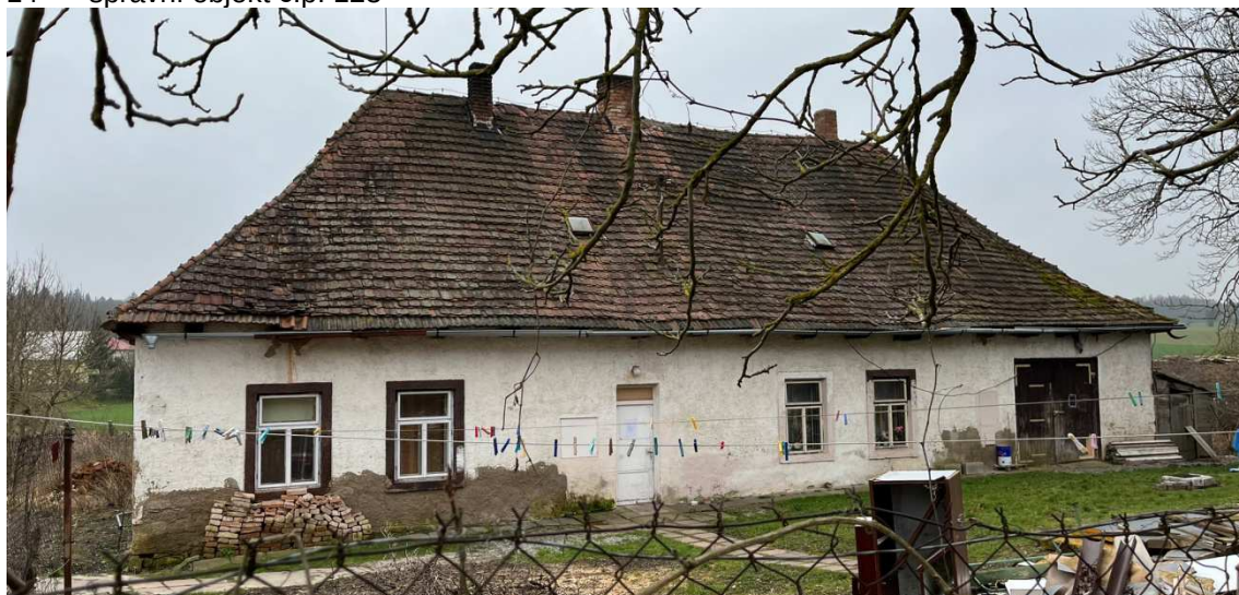
14 správní objekt č.p. 123
