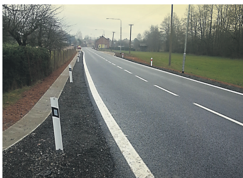
▲ II/567 Rtyň – Zbečín – Hronov včetně mostu
