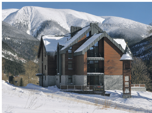
▲ Přestavba objektu Zvon, Špindlerův mlýn
