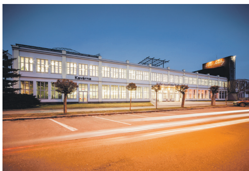
▲ Revitalizace továrny Vertex na Centrum celoživotního vzdělávání, bývalá továrna Vertex, Wonkova ulice, Hradec Králové
