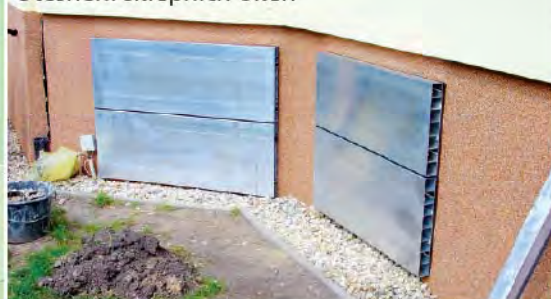
Utěsnění sklepních oken
