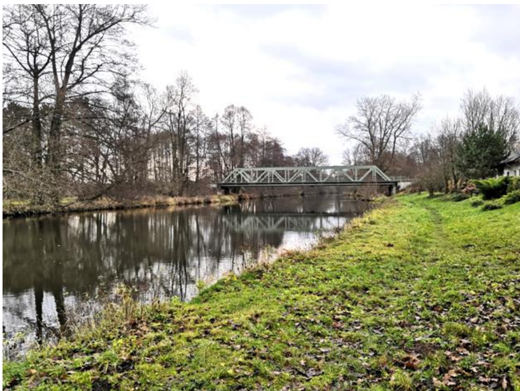
Obr. 1: Železniční most na spojené Orlici ř.km 32,644
