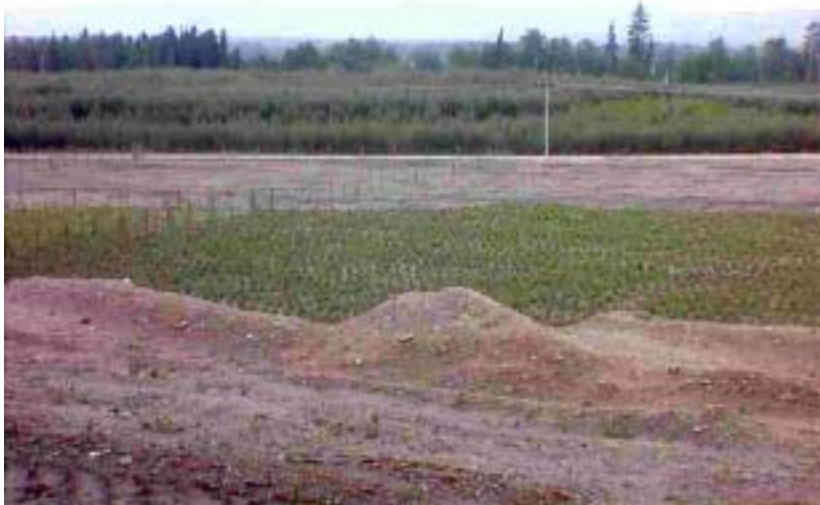
Světlá n.O. – kontinuální rekultivace za těžbou štěrkopísku nad hladinou spodní vody
