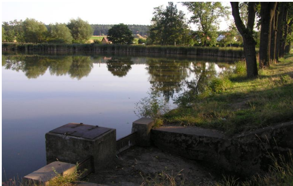
Obr.3. Hráz rybníka Roudnička s manipulačním zařízením
